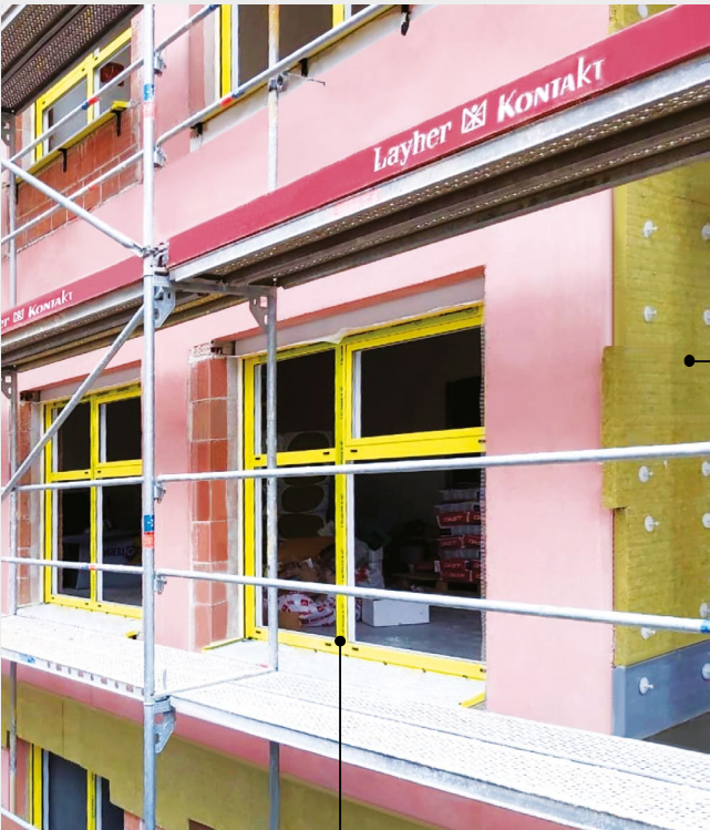
Dritare me dopio xham Termik për Efijencë energjitike dhe izolim ndaj zhurmave.
