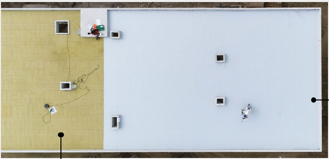
Tarracë e pajisur me barrierë për avujt me Termoizolim, me lesh guri Rockwool 10cm, membranë Hidroizoluese me gomë Alwitra EVALON gjeotekstil dhe çakull.
